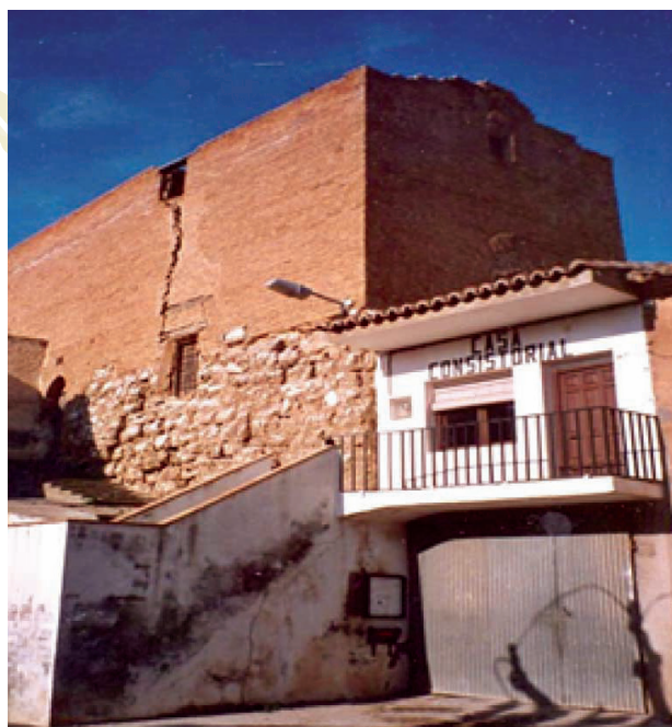
Torreón de los Condes de Bureta en Pleitas
