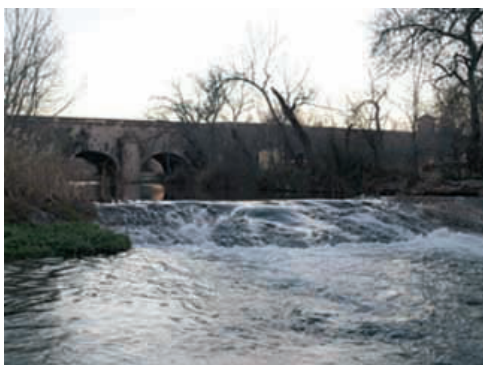
Acueducto del Canal sobre el río Jalón
